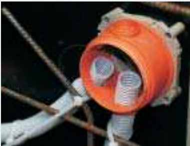
Смонтированные гибкие трубки в корпусе KBT.
