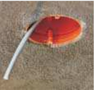
Коробка KBT... с выведенным проводом, готовая для установки люстрового крюка KBP...
