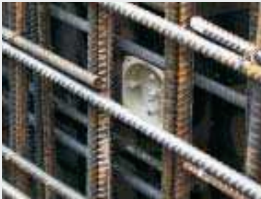
Крышка KBV, прикрепленная на опалубке.
