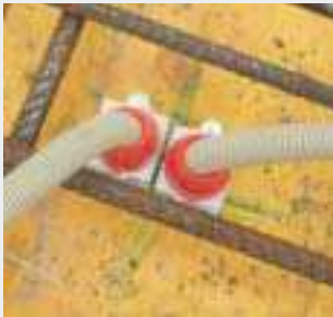
Пример использования концевых втулок и наконечников.
