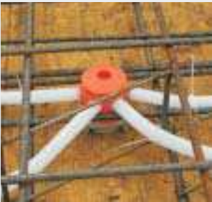
Пример использования в горизонтальной опалубке.
