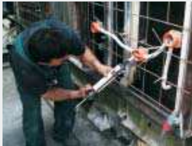
Герметизация вводов (шпатлёвка).
